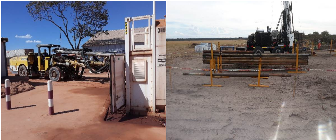
Photo 11: Le jumbo pour le forage dans la mine et Emilia pour le forage carottant en surface
