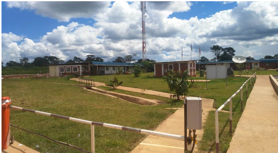
Photo 5: L'infrastructure existante de la mine de Kansoko
