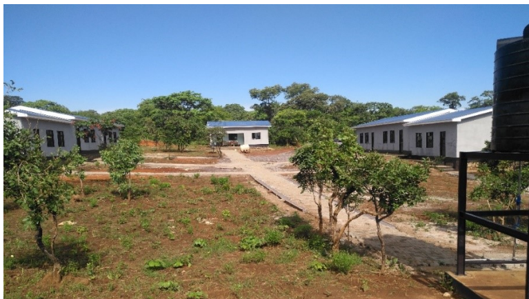
Photo 76: Ecole primaire Muvunda construite au village Muvunda par KAMCO en compensation de la perte d'accès aux ressources naturelles contenues dans le primetre de la mine de Kakula
