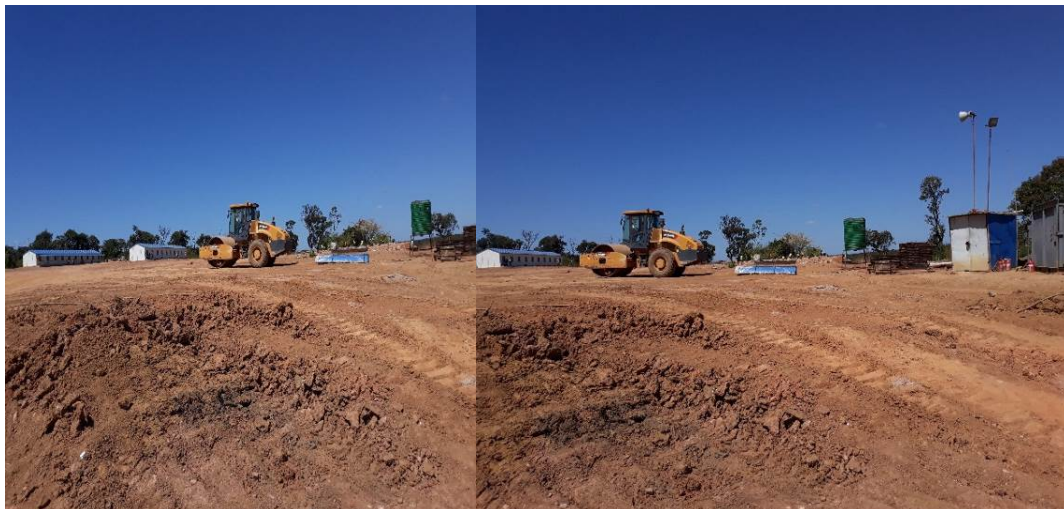
Photo 7:L'infrastructure de surface en construction sur le site de la mine de Kakula ouest
