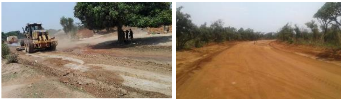
Photo 66: Rehabilitation des routes.
